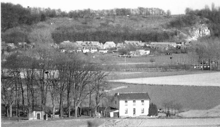
FIGUUR 3. Het van boom- en struikopslag ontdane deel van de helling ten zuiden van de voormalige Tiendschuur, gezien vanaf de Louwberg. Geheel rechts is nog een deel van de voormalige Nekami-groef herkenbaar (situatie 1989; foto: B. Graatsma).
